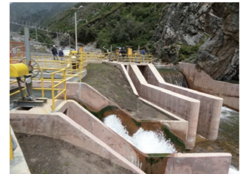
水力発電所の取水口(パルカ鉱山近郊)
